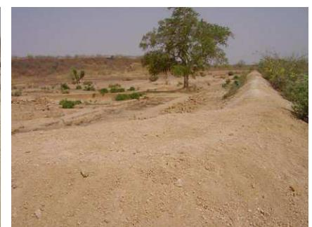
La tranchée de déviation des eaux pluviales en amont du futur périmètre bocager de Cissé-Yargho est terminée. Cette tranchée de 1 m<sup>2</sup> de section, sur 1.155 mètres de long, renforcée en son aval d'une digue de 700 mètres de longueur, assurera la protection du périmètre contre les eaux sauvages (*eaux de ruissellements de la savane et des zones dégradées situés en amont du périmètre*).
