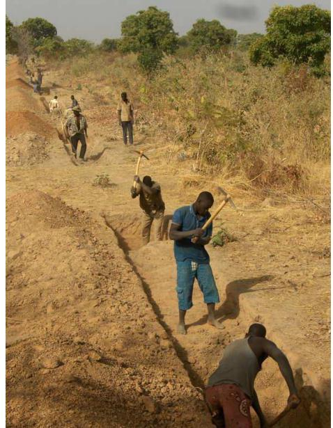
2. le renforcement du micro barrage de Douré. Ce barrage de protection du périmètre de Douré (aménagé en 2004), s'est révélé trop petit lors des grosses pluies de 2007. Nous en rallongeons donc la digue pour contenir plus d'eau.
