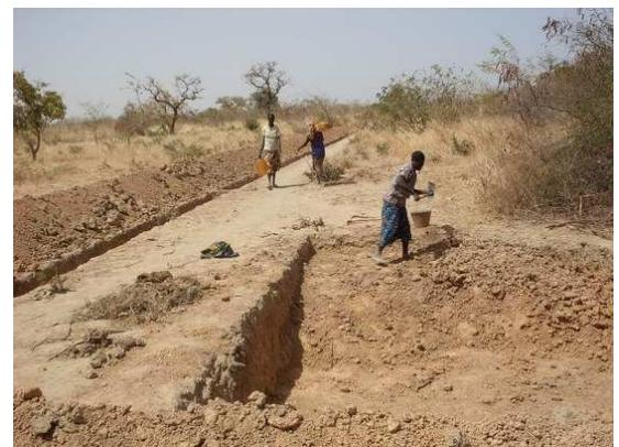
Vu les dégâts occasionnés par l'eau dans ce périmètre durant l'hivernage 2008, l agrandissement du canal de déviation du périmètre de Cissé-Yargho s'imposait. Nous élargissons ce canal sur toute sa longueur et renforcerons également la digue pour mieux contenir les eaux sauvages de ruissèlement.
