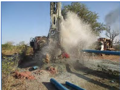
avons pu réaliser un forage positif avec un débit de 2.000 m<sup>3</sup>/heure. Grâce à cette disponibilité de l'eau au sein même du site, nous pourrons poursuivre plus sereinement les travaux d'installation des différents domaines (*habitations, verger, parc, etc.*).
