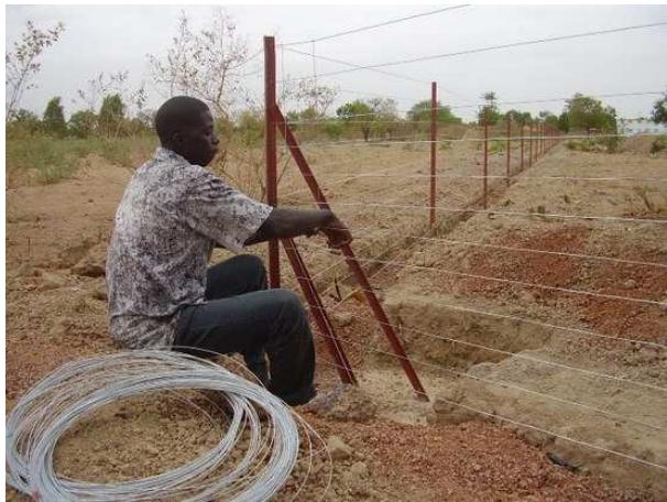
piquets de bois. Dans cette technique la maille du grillage est fabriquée sur place, imbriquée dans les poteaux métalliques. Cela permet de se protéger des voleurs qui ne pourraient emporter que des morceaux de grillage de 2 à 3 mètres.
