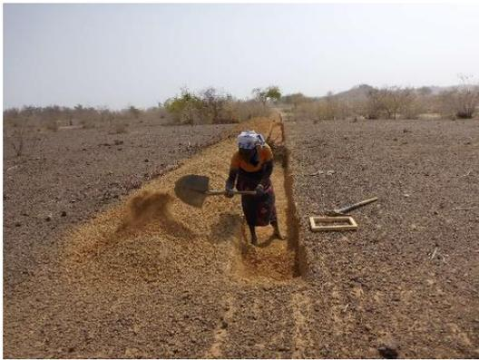
Le creusage des tranchées permet de faire des levées de terre pour confectionner des diguettes en terre autour de chaque champ afin de limiter l'érosion. Ces diguettes
