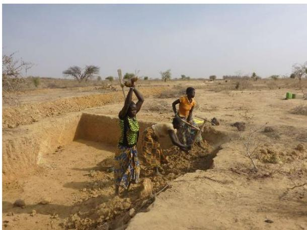
Le périmètre de Lebda est composé de 36 lots d'une dimension 160 X 160 mètres et chaque lot est composé de 4 champs d'une dimension de 160 X 40 mètres. Dans chaque champ il y a au moins une mare d'infiltration dans l'angle le plus bas du champ. Ces mares facilitent l'infiltration des excès d'eaux pluviales dans les nappes phréatiques. Pour
