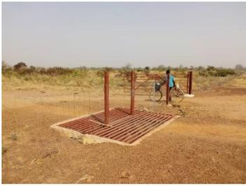
Le périmètre Lebda est entièrement clôturé avec 4 255 mètres de grillage. 1 418 piquets en fer galvanisés supportent le grillage qui est surmonté d'un barbelé. Pour faciliter l'accès au périmètre de Lebda 4 portes barrières et 4 portes couchées ont été installées.
