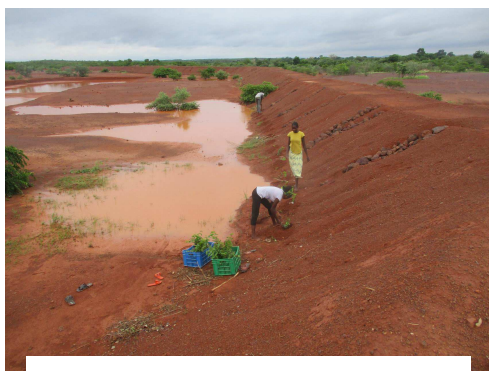
Plantation d'arbres sur la digue
