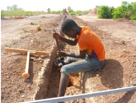
Creusage des trous des piquets
