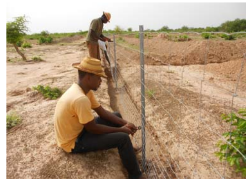
Pose du grillage et du barbelé
