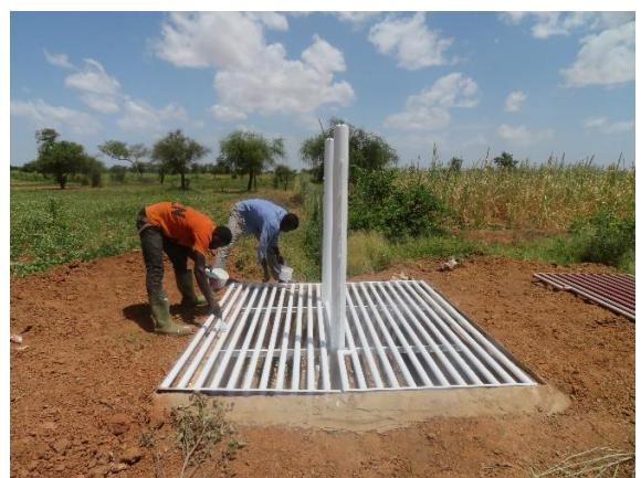
donnent l'accès aux bétails suivis, aux engins agricoles et aux charrettes. La peinture permet de lutter contre les attaques de rouille.
