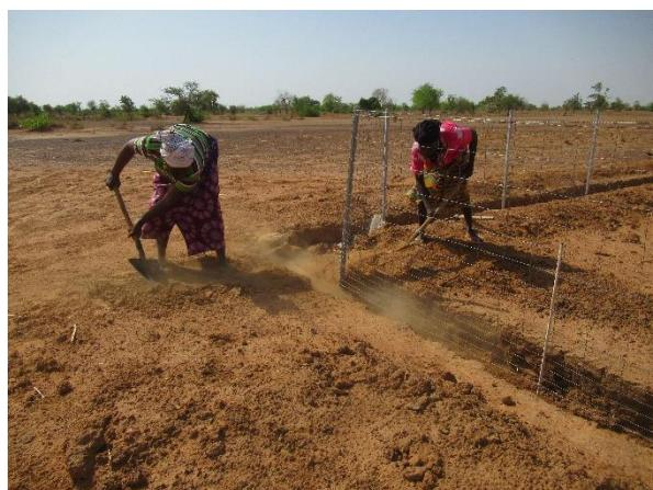
Cette activité intervient après le creusage des trous de piquet à l'intérieur le long de la tranchée de la clôture. Il s'en est suivi, l'implantation des piquets, la fixation du grillage, la pose d'un fil de galvanisation pour le maintien du grillage puis le rebouchage de la tranchée.
