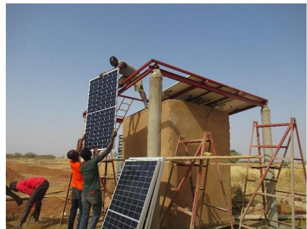
entourée d'un hangar. Elle sert de stockage de batteries et le toit sert de support aux panneaux solaires.
