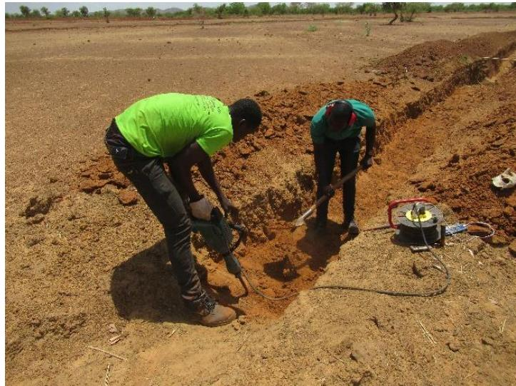
de creuser une tranchée racinaire à ce niveau pour faciliter plus tard la fixation des racines arbres qui seront plantés. Et pour venir à bout de la dureté de la roche en place, nous avons fait appel au marteau piqueur. Un premier a été mis à notre disposition par TERRE VERTE qui malheureusement n'a pas tenu dans ces conditions. Alors, nous avons payé un autre plus performant qui va nous
