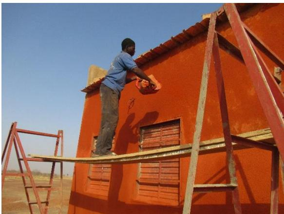
début de l'année nous avons effectué le crépissage, les raccordements, la mise des carreaux des marges, la mise de la chaux vive à l'intérieur, la mise de la peinture des portes et fenêtres et la mise du tyrolienne à l'extérieur.
