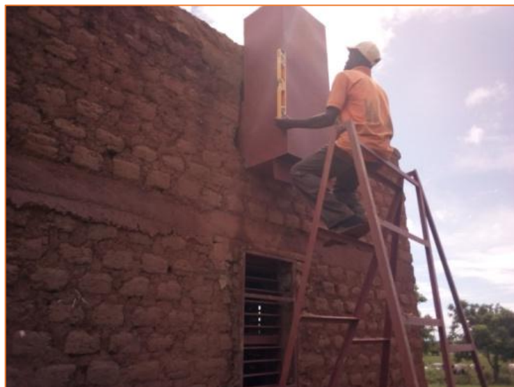
Figure 24: pose de l'aération du premier logement visiteur
