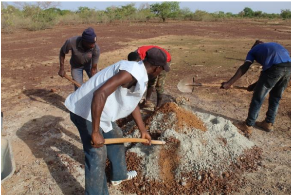
Figure 29: mélange du ciment pour la construction des poteaux
