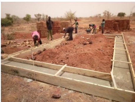
Figure 21: fondation du logement
