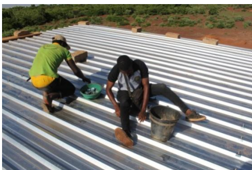
Figure 23: Tôlage du bâtiment magasin
