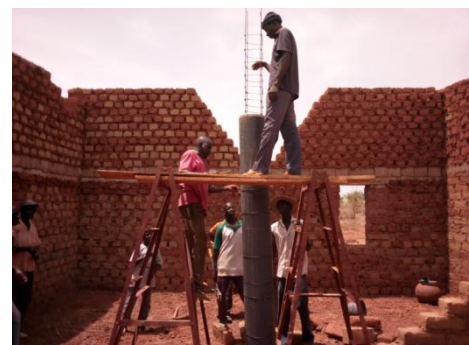
Figure 22: construction des piliers du bâtiment magasin
