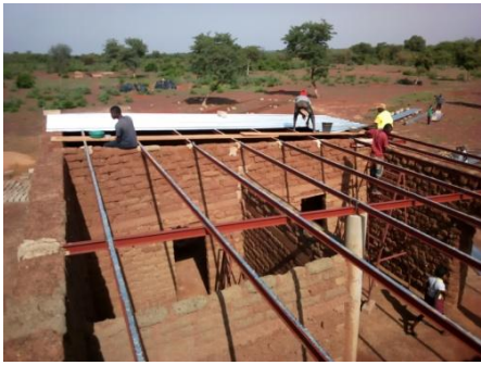
Figure 18: pose des IPN du bâtiment magasin
