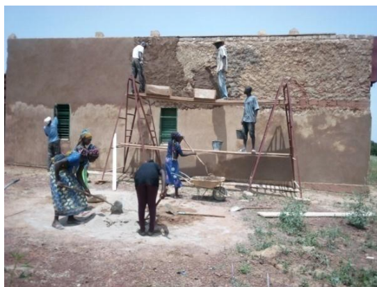
Figure 27: Crépissage des murs internes du magasin
