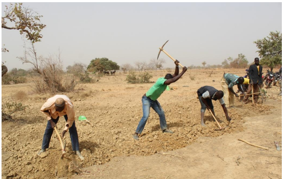
Figure 13: creusage de la terre pour le banco
