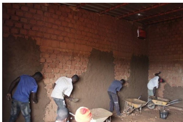
Figure 26: crépissage des murs externes du magasin
