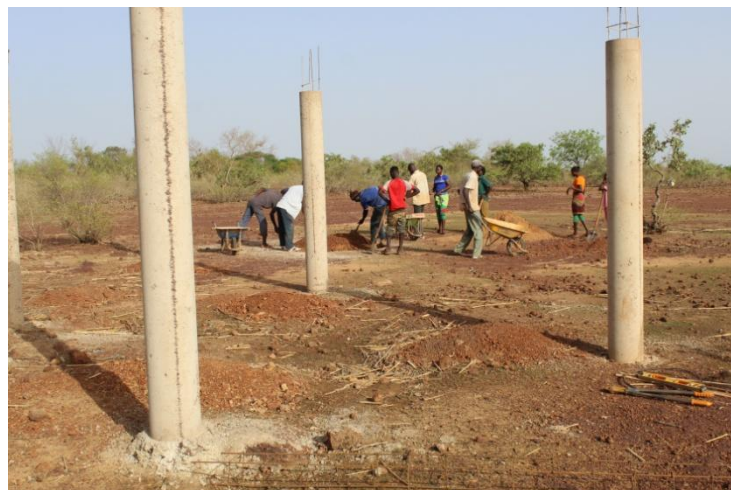
Figure 30: poteaux construits du hangar
