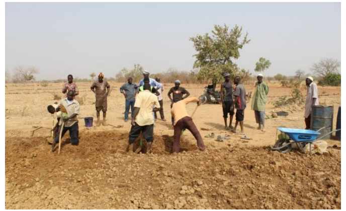
Figure 14: mouillage et malaxage de terre creusée transportées avec des tricycles dans les lieux de construction des premiers bâtiments.
