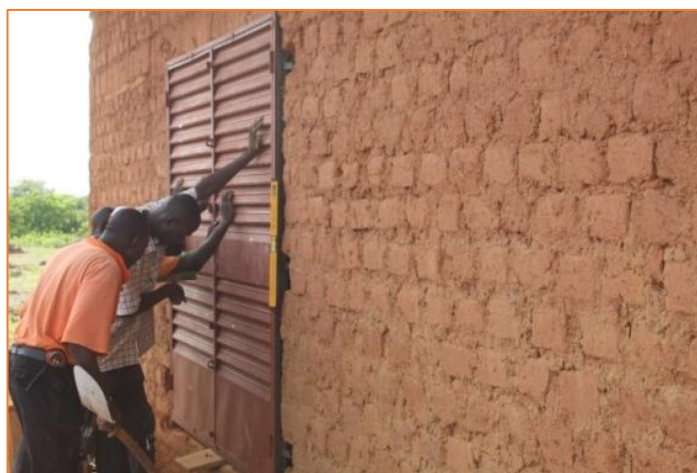
Figure 25: pose de la grande porte du bâtiment magasin
