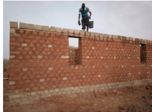
Figure 20: chainage du bâtiment magasin
