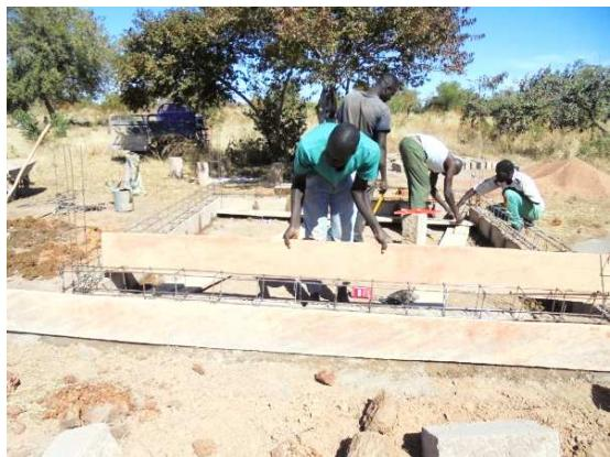
Dans la même dynamique nous avons entrepris la construction de porte couchée, de porte barrière, un bassin définitif pour la pépinière de la ferme pilote. Le bassin permettra de stocker l'eau et faciliter l'arrosage des plants. Il a une capacité de neuf (09) m<sup>3</sup>. Pour ces réalisations nous avons fait appel à un maçon expérimenté de l'Association ZORAMB NAAGTAABA
