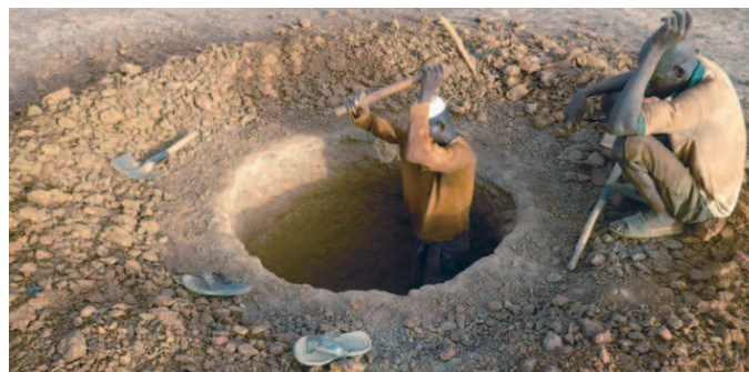
Deux hommes en plein creusement d'un puits racinaire.
