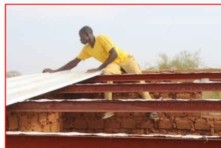
Pose de la toiture d'un bâtiment
