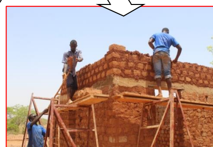
Construction de murs d'un bâtiment
