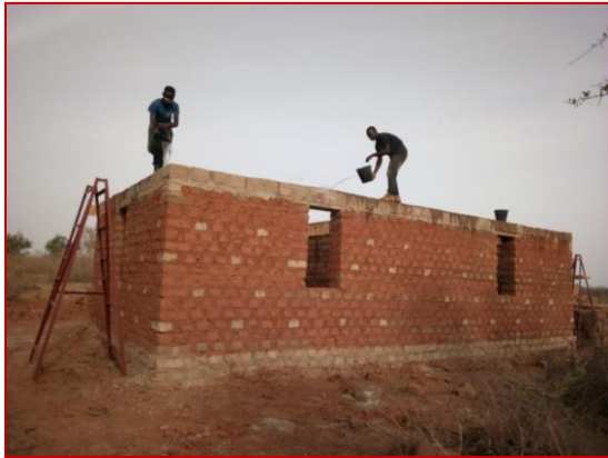
Arrosage du chaînage du magasin/bureau
