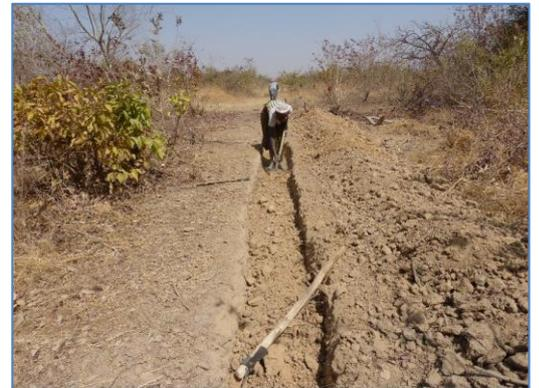
À Lindi particulièrement, il a fallu réaliser en amont du périmètre un bulli de protection afin de dévier les eaux en provenance des collines situées à environ 200 mètres. L'eau recueillie dans la mare servira également pour l'abreuvement du bétail.
