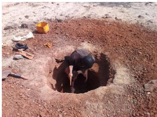
au niveau du village de Konéan où la route passe sur une zone très dure. Près d'une centaine de puits racinaires ont été creusés avec une profondeur allant jusqu'à 4 mètres afin de dépasser la partie latéritique pour permettre aux arbres qui seront plantés de bien se développer. La population s'est mobilisée pour le nettoyage de la nouvelle piste pour la rendre praticable.
