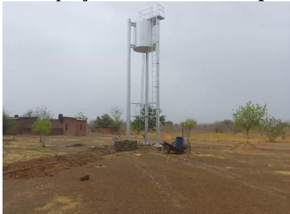
forage à grand débit situé dans le périmètre de Nabdogo à 3 kilomètres de la ferme. Ce forage va alimenter un château d'eau situé à l'intérieur de la ferme. Le château d'eau et les tuyaux sont déjà installés. Il ne reste que quelques petits travaux avant de voir l'eau potable couler dans les robinets de la ferme après de 13 ans d'attente.
