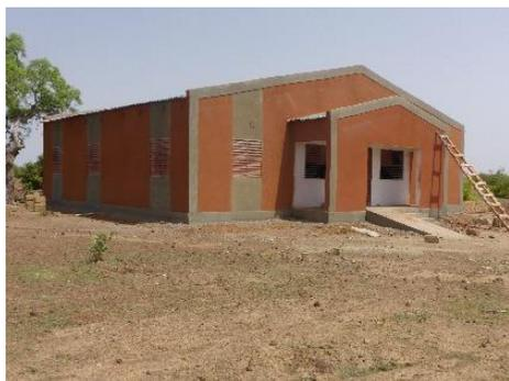
**Au CSPS (Centre de Santé et de Promotion Sociale) de Goèma**, le chantier de construction du dispensaire et du dépôt MEG tire vers la fin. Les travaux de finition (*peinture, tyrolienne*) sont en cours. La réception provisoire du chantier sera faite en juin.
