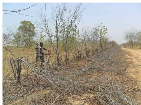
**L'arpentage de la piste de Goèma-Toéghin-RN3** est en train d'être fait par les techniciens de la ferme. Cette piste à terme sera longue de près de 11 km. Pour le moment plus 6 km ont été totalement arpentés avec des bornages qui matérialisent les trous des futurs arbres de la piste. La largeur de la piste est de 14 m. la population locale s'est fortement mobilisée pour défricher et dessoucher les 6 km déjà arpentés.
