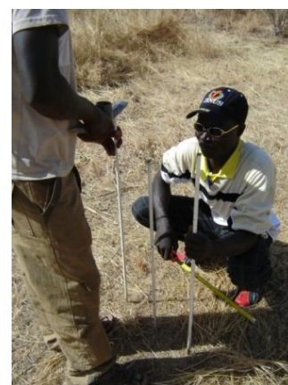
Photo 9 : piquetage de la largeur de la tranchée
