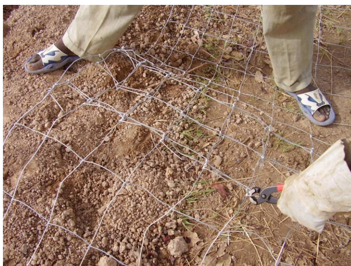
Photo 25 : réalisation d'un raccord de grillage
