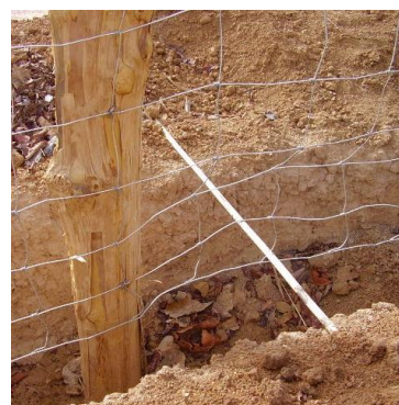
Photo 23 : piquet guidant la pose du grillage
