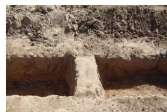
Photo 12 : aspect d'une cale une fois la tranchée creusée
