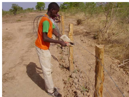
Photo 26 : fixation grillage/barbelé
