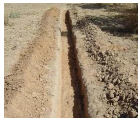
Photo 14 : la terre fertile de surface a été placée à droite, la latérite rouge à gauche
