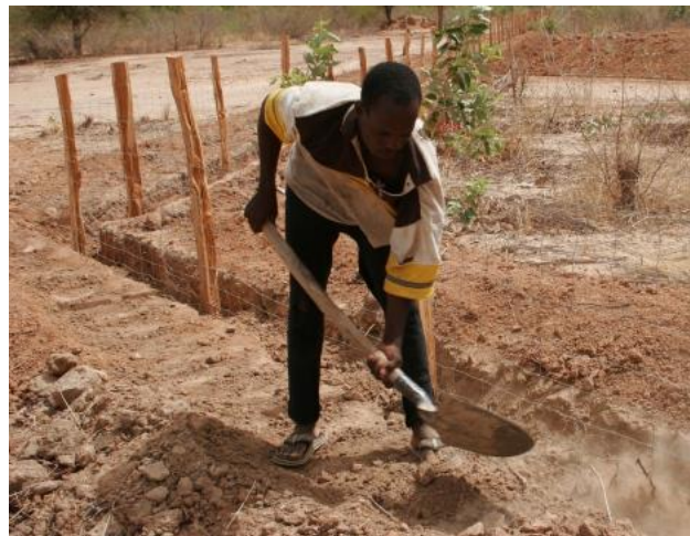
Photo 27 : rebouchage de la tranchée
