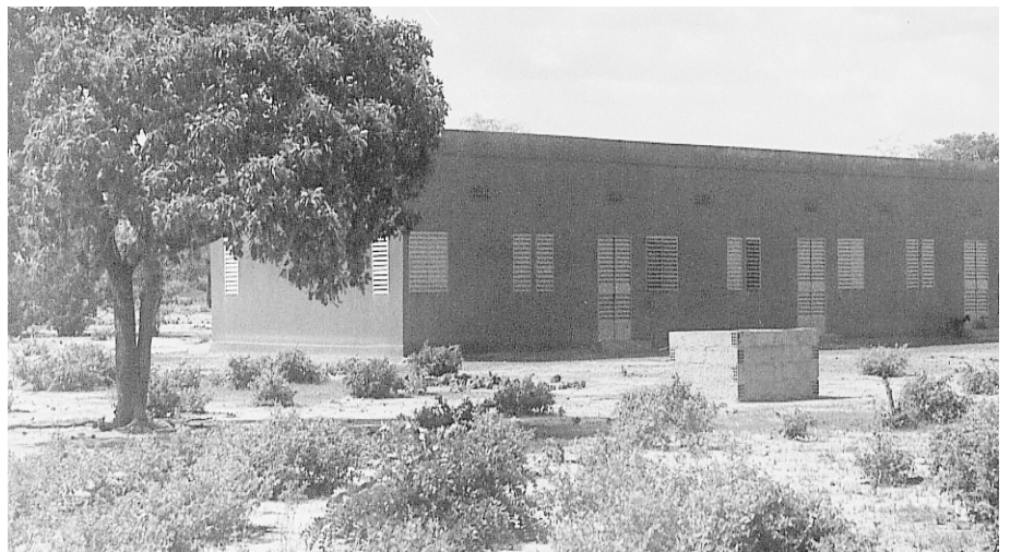
L'école de Douré construite en 1995
