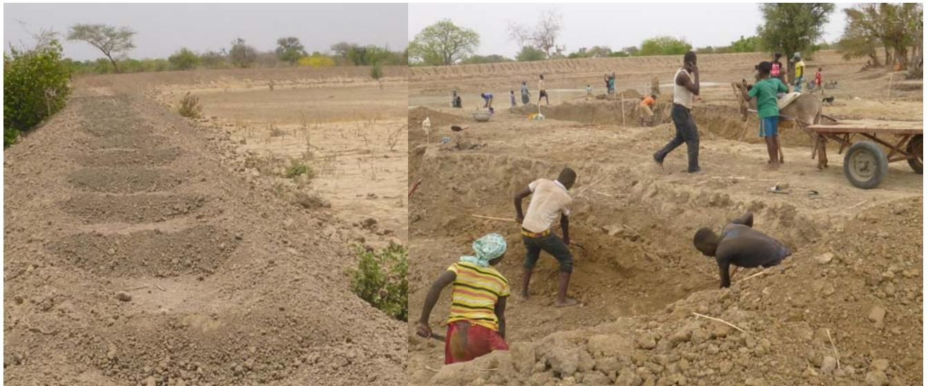
Suite aux grosses pluies de la saison hivernale 2015, certaines diguettes du dispositif antiérosif du périmètre de Gourbaré avaient cédé. Nous les avons réparées et procédé au traçage des axes des champs. Les trous des arbres sont en cours de creusement et bientôt, les agriculteurs passeront au reboisement.
