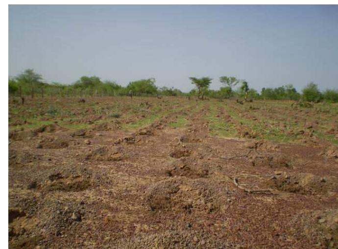
**L'efficacité et la capacité de rétention de nos ouvrages** de gestion des eaux de ruissellement ont pu être testées par ces premières pluies de juin, surtout celle du 10 juin (45 mm). Tous les ouvrages (diguelettes, tranchées et mares de récupération et d'infiltration) réalisés en 2010 sont en train de donner satisfaction.
