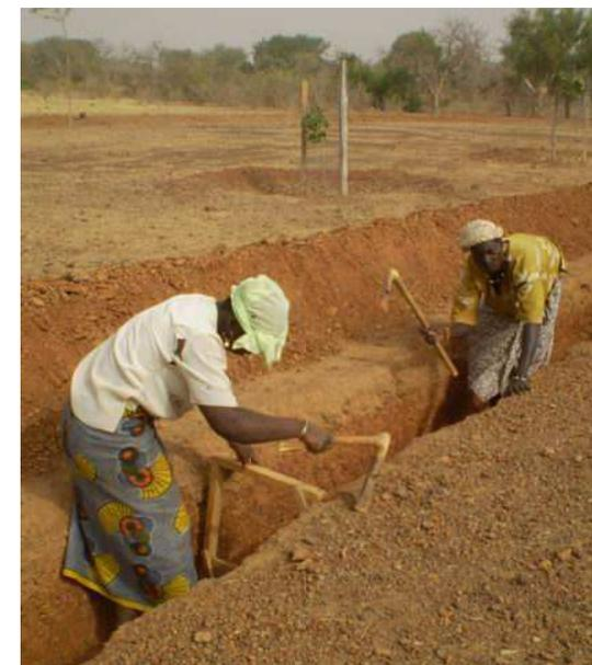
Pour amortir l'érosion des sols dus au ruissellement massif des eaux sauvages, nous avons réalisé à l'est de la ferme et au côté sud du périmètre Manegrewayan (« Sondré » ancienne appellation de cette zone) des tranchées et banka de récupération et d'infiltration de ces eaux.
