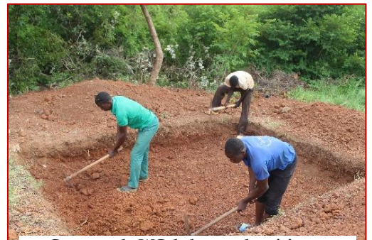
Creusage du WC de la cour des visiteurs
