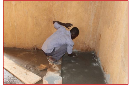
Construction de la chape d'un logement visiteur
