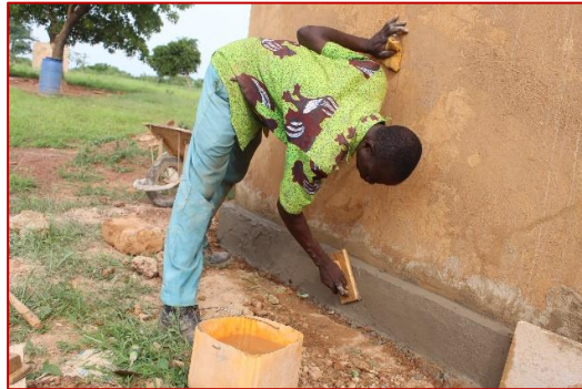
Construction de ceinture autour d'un logement visiteur
