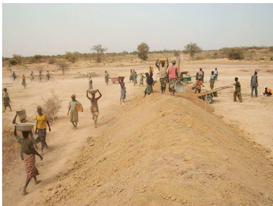
Les travaux du bulli avec déversoir de Tibkoulga ont démarré en janvier avec le creusage de la tranchée d'étanchéité, rapidement suivi de la confection de la digue elle-même, réalisée avec la terre de creusement du canal et du bulli. Ce sont 164 équipes de contractuels qui se sont retrouvés sur ce chantier, soit environ 800 hommes et femmes qui auront trouvé un emploi rémunérateur de quelques semaines dans le cadre de
