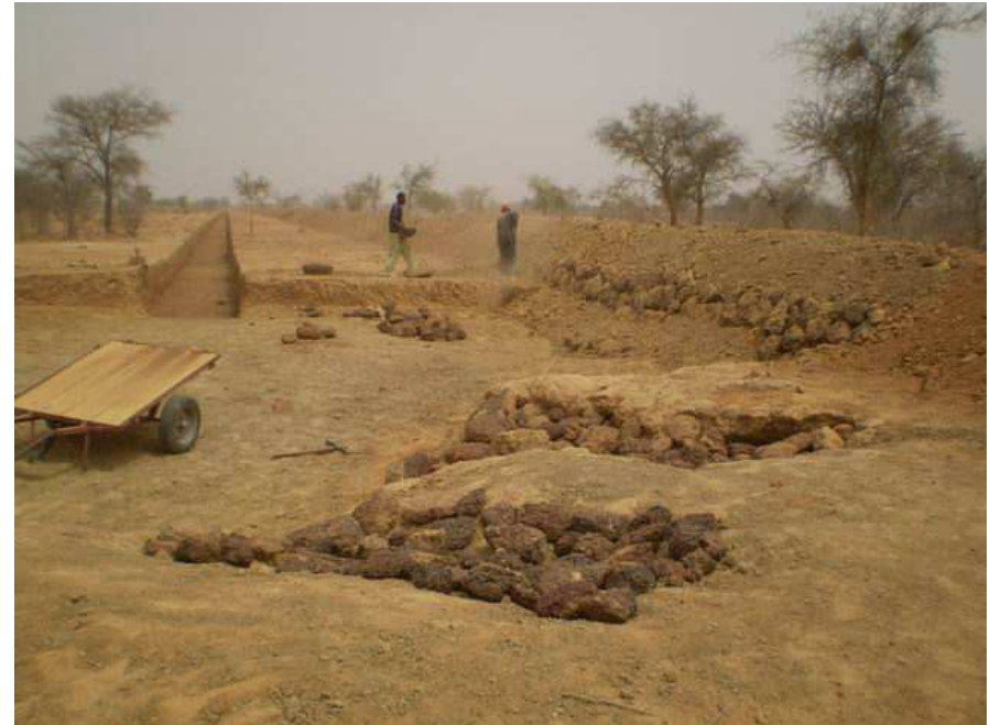
Travaux de finition de la déviation d'eau.
