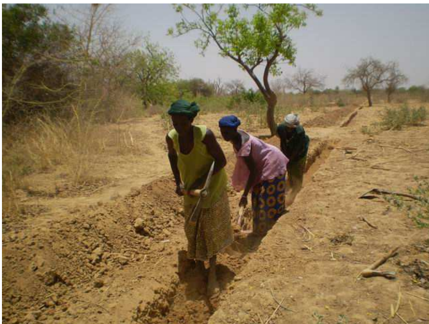
Creusage des tranchées
