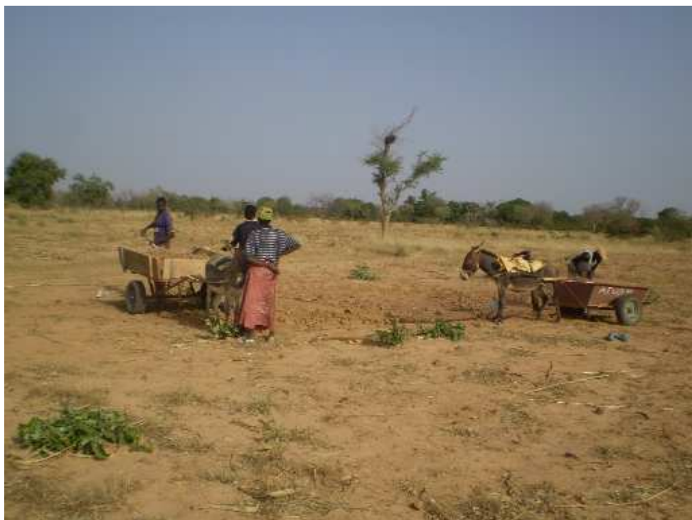
Creusage et ramassage de la terre sablonneuse.
