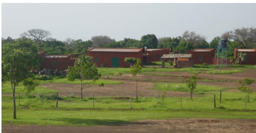
Ferme pilote de Filly.
