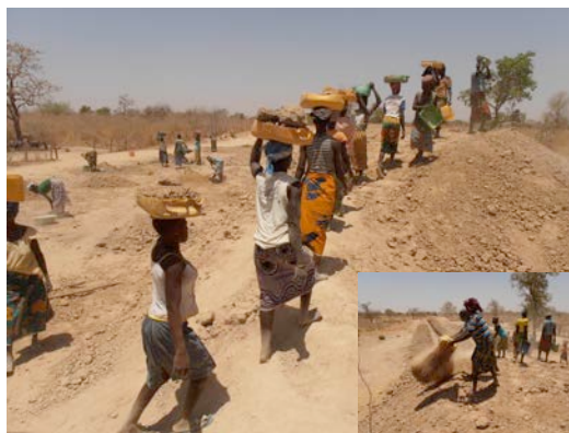
Aménagement du bulli-route de Cissé-Yargho
